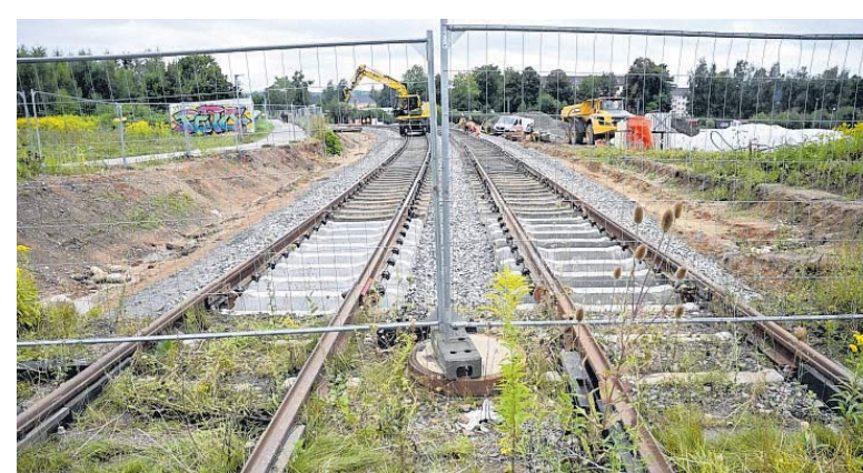
Bis auf Höhe des Bauzauns lag der Gleisstumpf an der Fraunhoferstraße. In den vergangenen Tagen wurde der Anschluss an die Neubaustrecke geschaffen. Die Route nach Aue ist damit komplett. FOTO: ANDREAS SEIDEL
